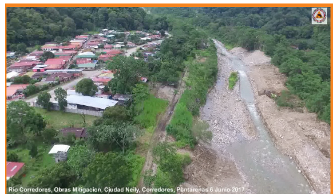
Figura 9. Sobrevuelo río Corredores, obras de mitigación Ciudad Neilly, Corredores, Puntarenas. Fuente: UIAR, 2017.
