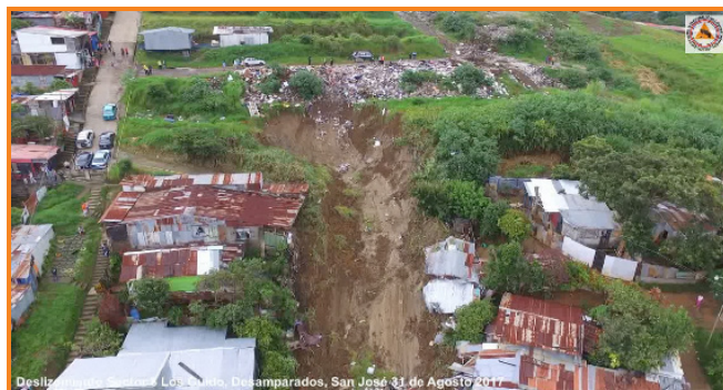
Figura 5. Sobrevuelo deslizamiento Sector 8, Los Guido, Desamparados, San José. Fuente: UIAR, 2017.
