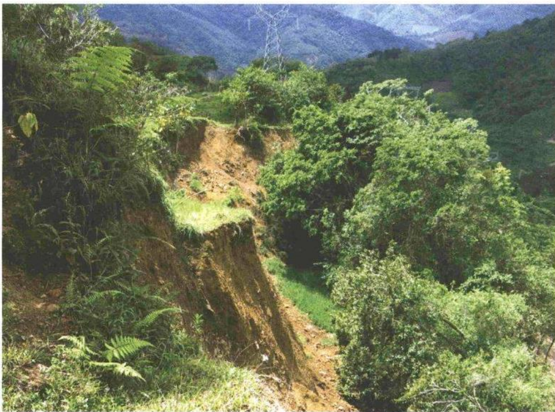
Deslizamiento Juco, Orosí de Cartago.
