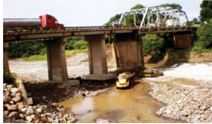
Figura No.3. Sobre explotación del cauce del río Barranca que ha llegado a erosionar hasta la base de los pilares del puente de la interamericana. (Fotografía del autor)
